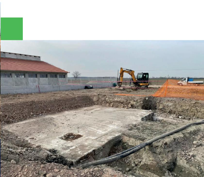
Se un serbatoio interrato viene dismesso (cioè messo fuori servizio), ci occupiamo di tutte le fasi del processo, dalla bonifica del serbatoio alla sua rimozione o iner-tizzazione in posto, compresa la preparazione della documentazione necessaria per ottenere i permessi ambientali, seguendo le indicazioni delle agenzie ambientali regionali (ARPA).
